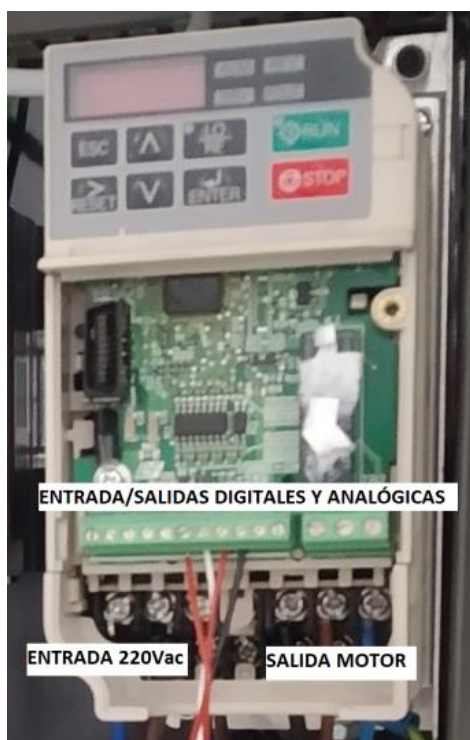
Figura 4: Variador de frecuencia
