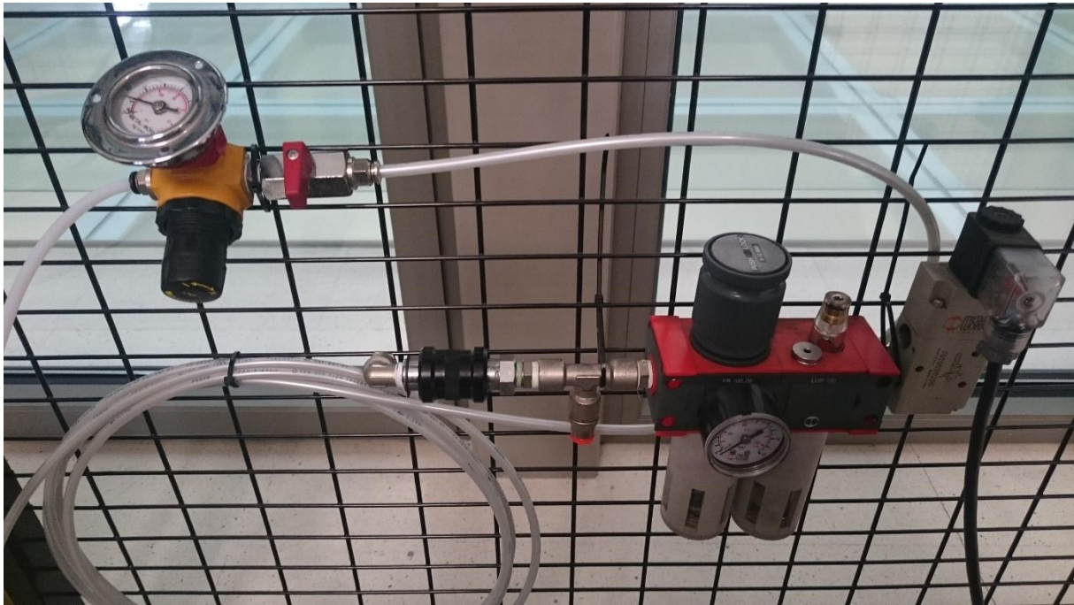
Figura 16: Instalación de sistema neumático.
