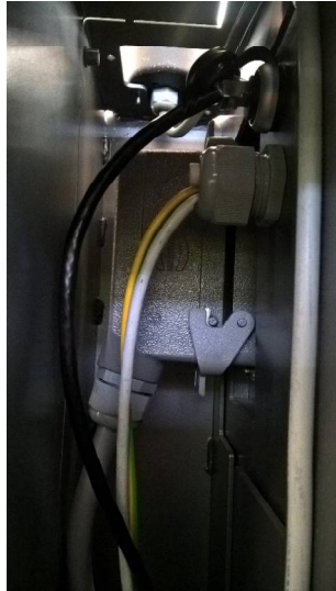
Imagen 3: Cable de red Ethernet RJ45 de categoría 6
